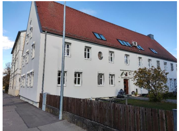
Abb. 17: Beispiel für ein Gebäude im schwäbischen Baustil mit großzügiger Freifläche (Museumstraße 14)
