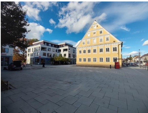
Abb. 6: altes Rathaus, um 1727 erbaut, mit südlich vorgelagertem öffentlichen Platz (Fuggerstraße 25)
